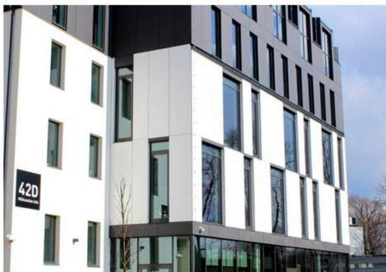
Biroju ēkas rekonstrukcija un biroju jaunbūve Mūkusalas ielā 42, Rīga, 2.kārta. Pasūtītājs "Mūkusalas Biznesa centrs". Projekts Pēteris Bajārs, "OUTOFBOX". Būvnieks "PRO DEV", projekta vadītājs Gatis Krastiņš. Būvuzraudzība FABRUM, Sanita Rubene.
